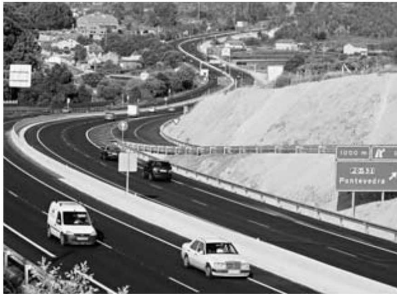
La autovía de O Salnés también fue construida recurriendo a la financiación privada | MÓNICA FERREIRÓS
