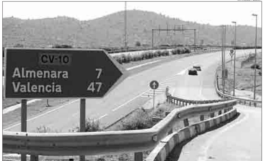
► Una entrada a la autovía de la Plana en el tramo que tendrá tres carriles por sentido en un futuro.
