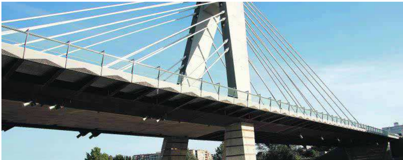
CIFRAS. El puente mide 165 metros de longitud y el pilono, 40 metros de altura. Está sostenido por 34 tirantes y dos torres de 31 metros de altura. /LP
